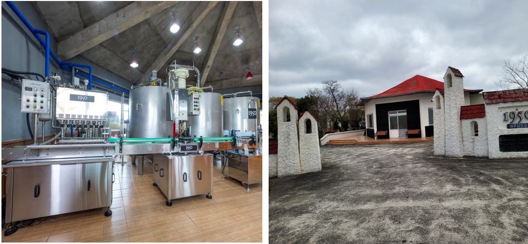
양조장 위치 : 제주시 조천읍 남조로 2064 <그림 4-2> 양조장 제조설비 공유현황
