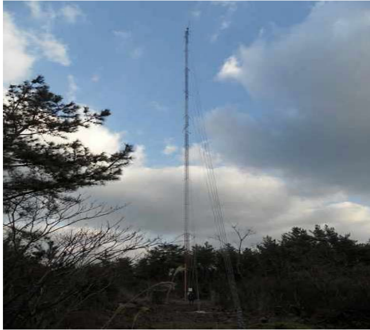
Fig. II-7 80 m tall met mast in Dongbok wind farm
