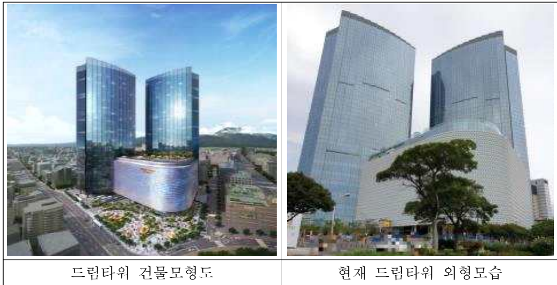
<그림 2-1> 드림타워 건물모형도 및 외형사진 6)
