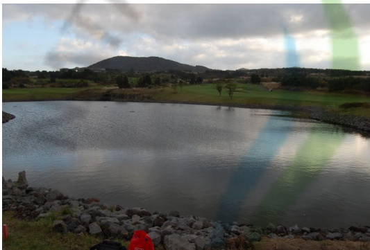
B골프장 오존처리시스템 설치
