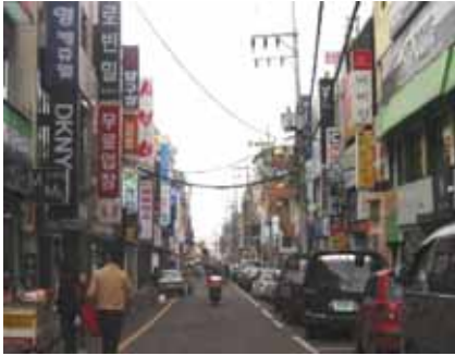
<사진 1> 무분별하게 설치된 SIGN
