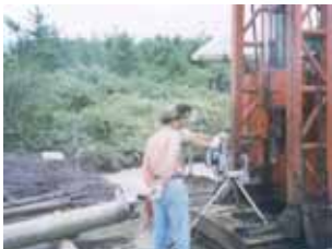
공내촬영 및 수직검층
