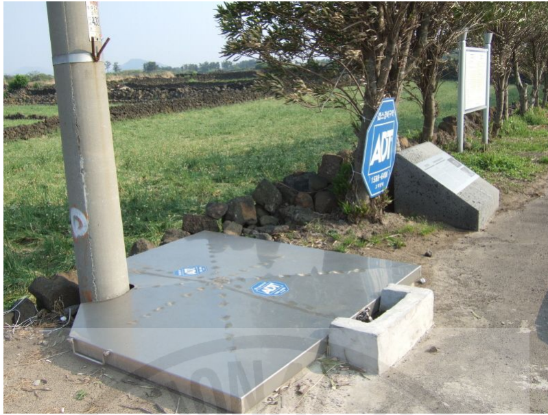
사진 11. 용천동굴 입구의 출입통제 밀봉시설
