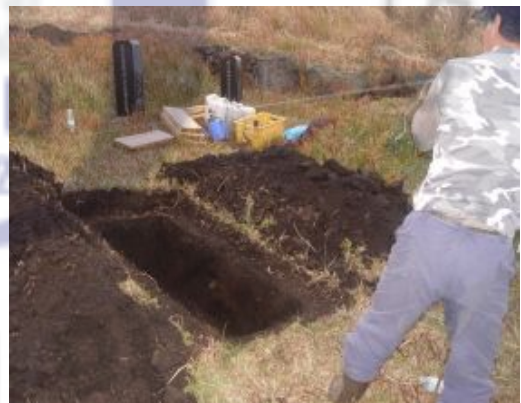
(사진22) 개광을 할 때는 먼저 줄을 놓고 정확하게 방향을 잡으며, 작업을 완료한 이후에도 다시 한번 확인한다.
